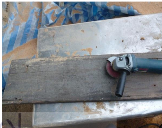
圖 4-35 用砂輪機打磨下方層板 (研究者拍攝，2014)
