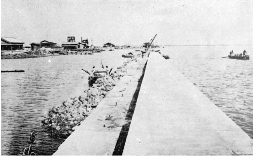
照片 2-2 打狗港築港工程岸壁工事之二
