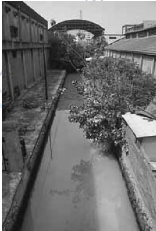
照片 3-2 大溝頂出海渠道
