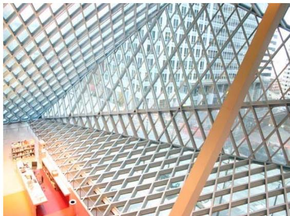
照片 4-1-31 整棟建築是由鑽石型的玻璃帷幕框架所構成的，並被不規則的玻璃帷幕所包覆住(資料來源：廖桂賢攝，2008.04.11)
