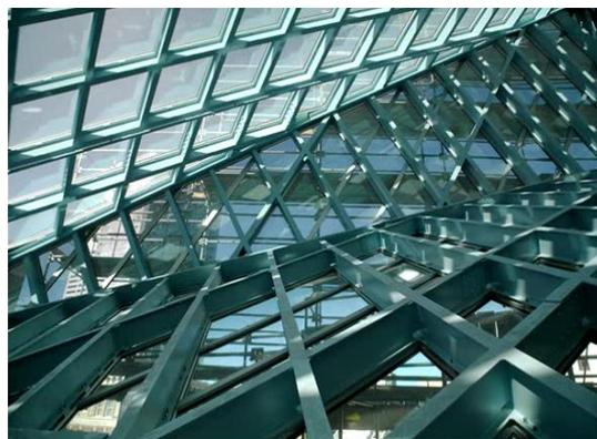
照片 4-1-32 西雅圖中央圖書館網狀鋼結構所包裹的折版狀建築外型(資料來源：西雅圖中央圖書館網站，2008.04.11)
