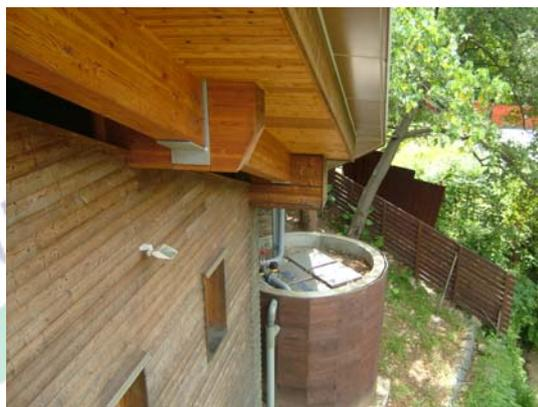
照片 4-2-14 北投分館綠化屋頂及斜坡草坡設計可涵養水分自然排水至雨水回收槽中(資料來源：研究者自行拍攝，2008.05.30)
