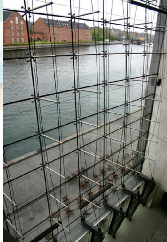
照片 4-1-64 全面玻璃帷幕牆，以預力的鋼索固定於屋頂桁架及位於一樓的「7」字型鋼基座(資料來源：廖桂賢攝，2008.04.11)
